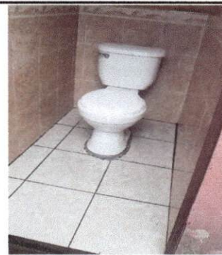
Foto 6: Instalado el nuevo inodoro. Remozamiento finalizado.
