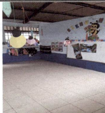
Foto 2: Piso cerámico colocado. Finalizado remozamiento.
