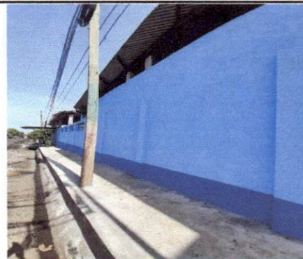
Foto 4: Banqueta de concreto finalizada lado derecho.
