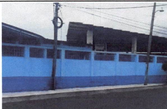
Foto 3: Banqueta de concreto finalizada lado izquierdo.
