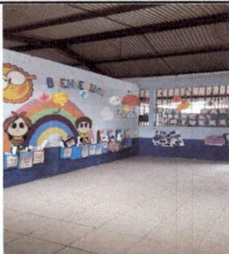
Foto1: Piso cerámico colocado. Finalizado remozamiento.
